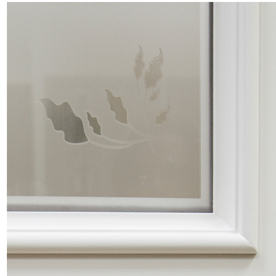
рисунок Дерево: печать лаком и пескоструй
